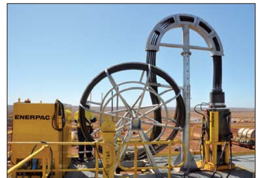
▼ 在澳大利亚某矿，包含顶升桩 ( Palm trees )、顶升附加装置、钢绞线卷取机和顶升楔套消耗品的八台444吨钢绞线千斤顶将把重达1500吨的12台球磨机顶升到20米高的轴承座上。
