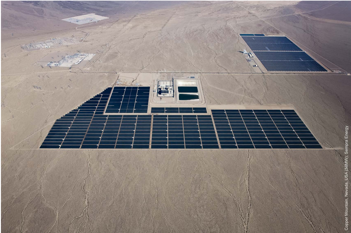
Bild 1-2 Ansicht des Copper-Mountain-Solar-PV-Kraftwerks, Nevada /4/
