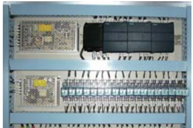
图 7：S7-1200 主控制柜及驱动电源
